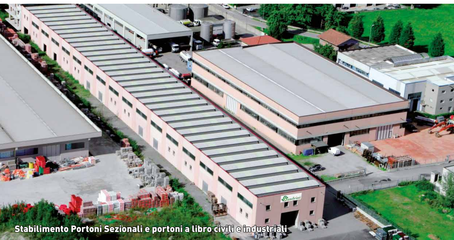
Stabilimento Porte in Legno
