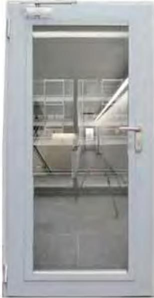
Anta di 53 mm di spessore in acciaio zincato di 0,7 mm di spessore tipo skinpass.
